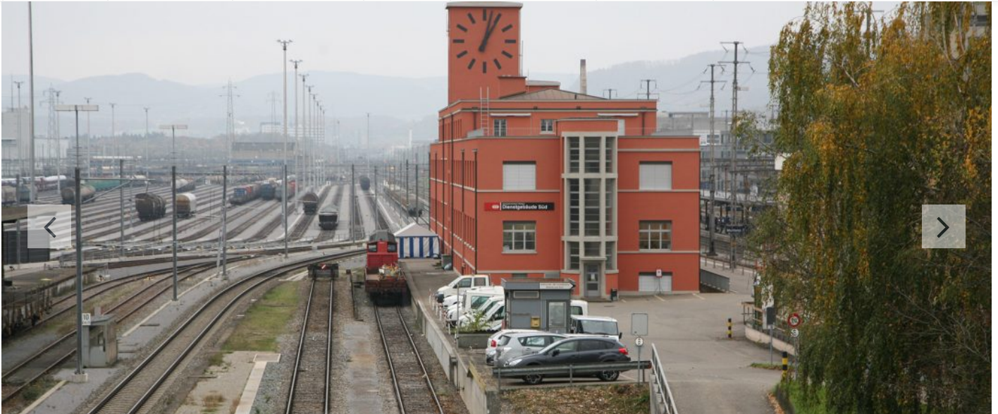
Dienstgebäude Rangierbahnhof, Muttenz, ©2013 F. Becker
